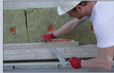
Mur en briques en cours de réalisation par un compagnon
